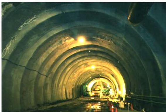
写真-1 構築したスリットコンクリート
