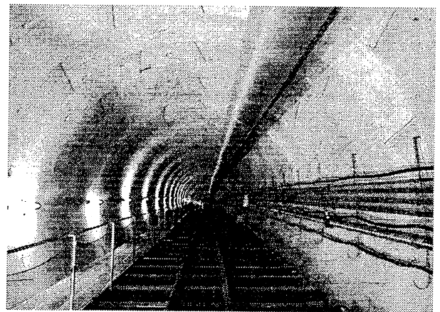
写真-4 ラッピングシールド工法施工区間状況
