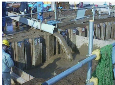
写真-9 埋戻し状況 (流動化処理土)
