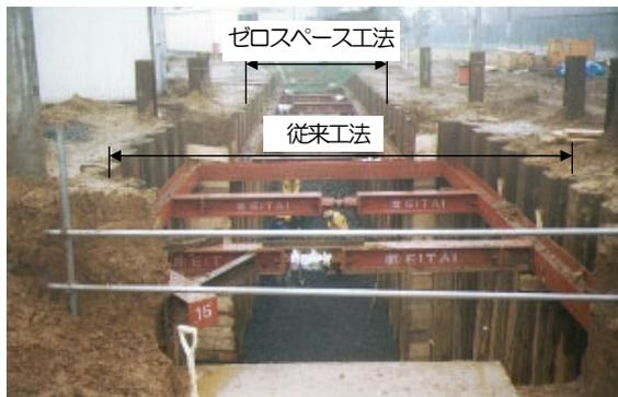
写真-2 実規模実験 (掘削幅比較)
