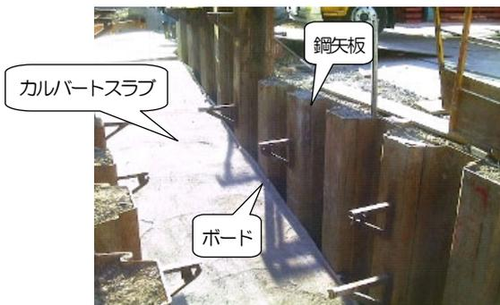
写真-8 構築完了
