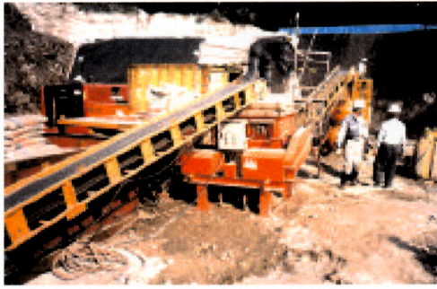
写真-1 遮水材吹付けプラント
