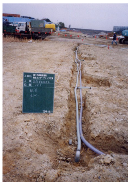
写真－１ 事前ガス抜き工配管
