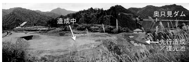
写真-2 代替湿地の状況
