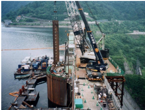
写真-3 取水口仮締切
