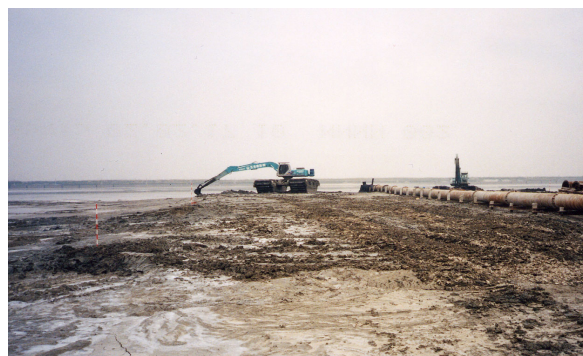
写真-4 泥上車の掻上げによる築堤造成状況
