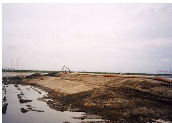
写真-4 中仕切堤全景
