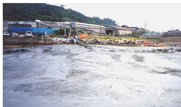
写真-2 打設状況
