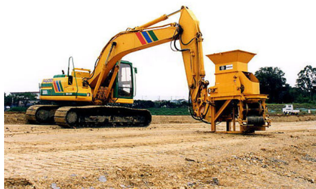
写真-2 専用撒きだし機（全景）
