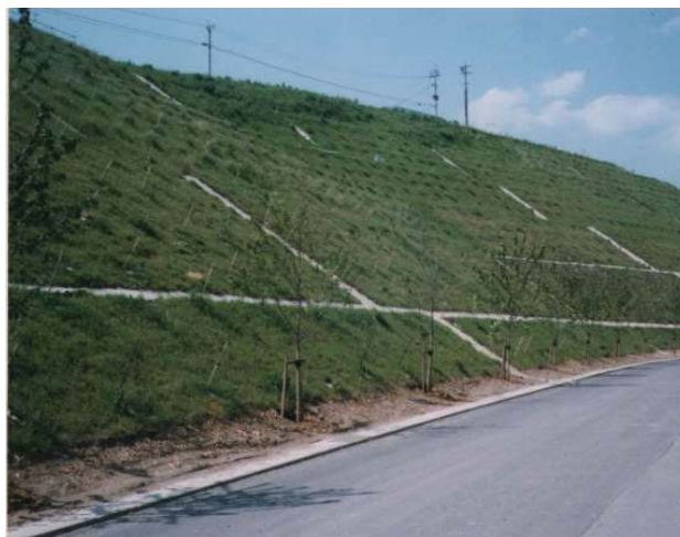
写真-5 施工後 2 ヶ月植生状況
