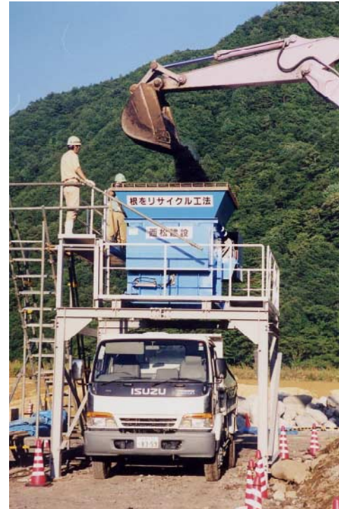
写真-3 2軸ミキサによる混合
