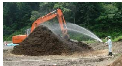
写真-2 仕込み(散水)
