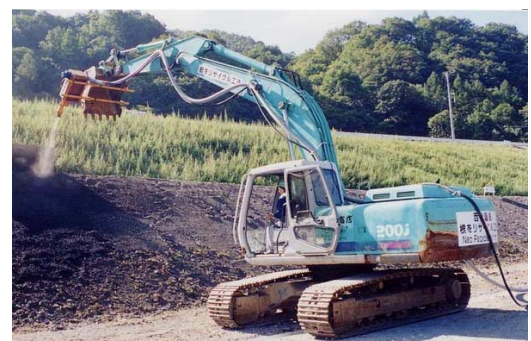
写真-5 のり面への吹付け
