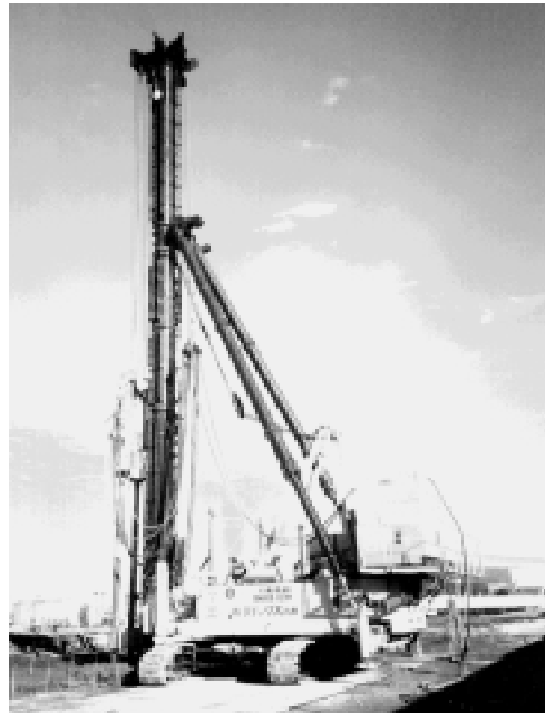
写真 - 2 施工機械
