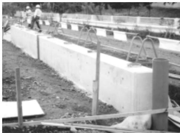
写真 - 6 完成した擁壁
