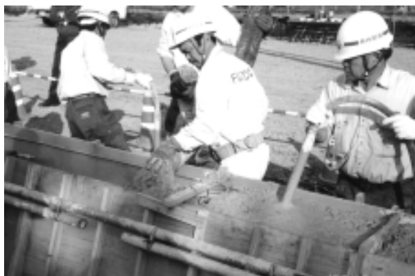
写真 - 5 コンクリートの打込み状況
