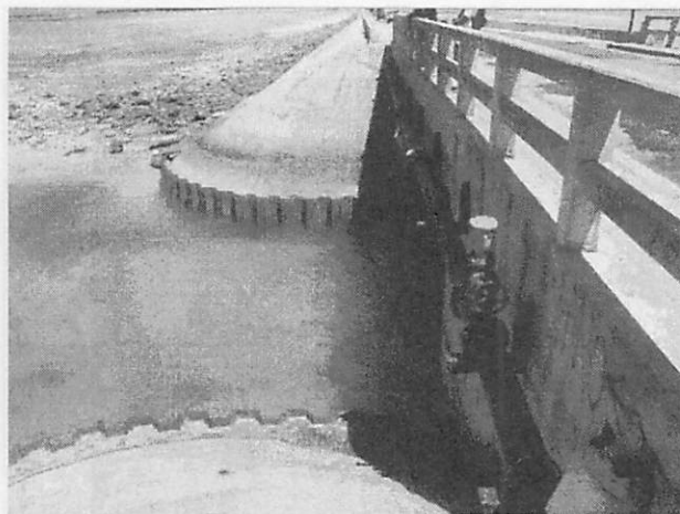
写真-2 ニッポン・コースウェイ中間のリーフに建設されたパッセージ（キリバス、タラワ環礁）
