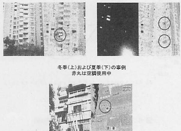
図-13 赤外線サーモビューワーによる空調使用率調査事例
