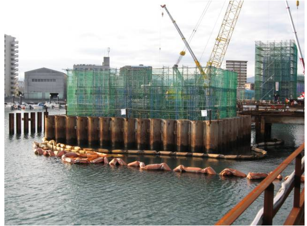
写真-6 汚水（濁水）の拡散防止用のフロート
