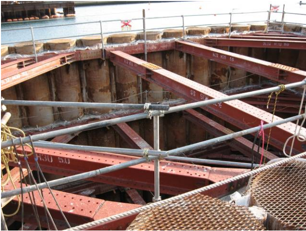
写真-4 墜落防止のための手すり (2009年6月1日以前に撮影)
