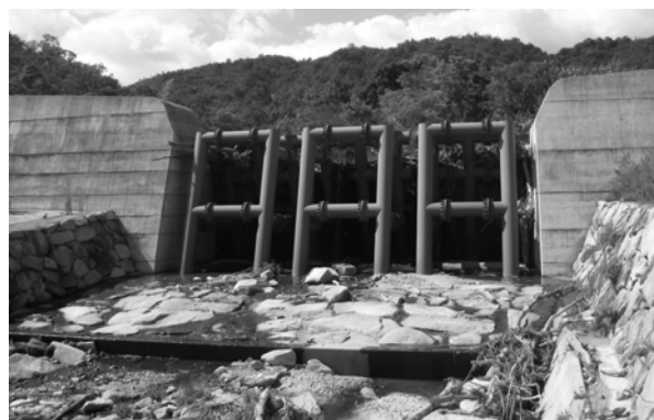
写真-1 鋼製透過型砂防堰堤
