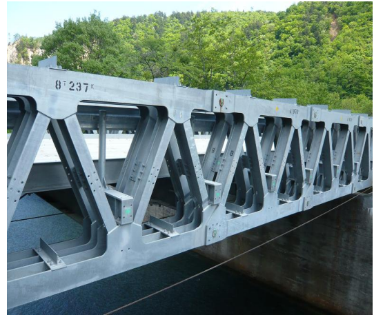
写真-1 国土交通省の応急橋架設状況(岩手県石淵ダム: 東北地整)
