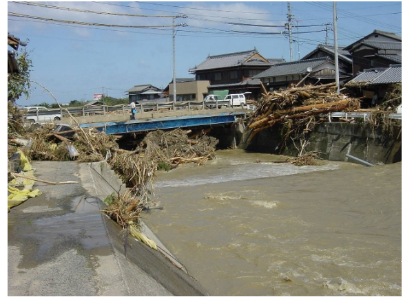
図-13 愛媛水害において流木が堆積し左右岸の溢水災害 10)
