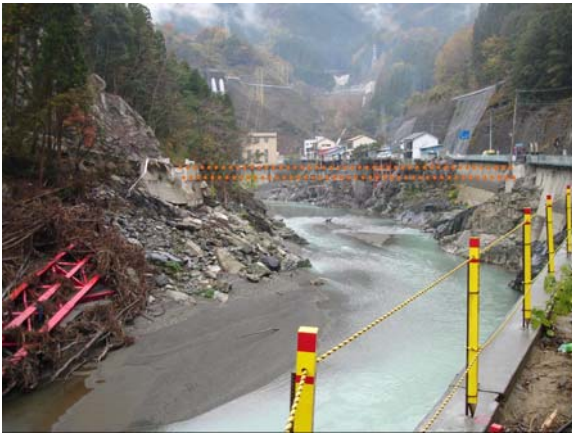
図-8 宮崎水害において流出した合成桁 3)
