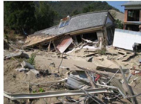
図-3 広瀬地区の被害状況（撮影 20050924）
