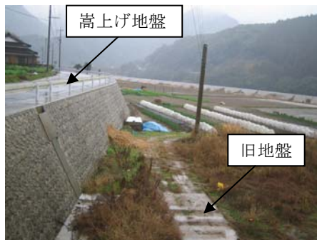
図-13 嵩上げ事業完了後の状況(撮影 20100301)
