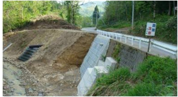
写真-4 護岸と横断排水施設の被災箇所の復旧状況 (主)金沢湯涌福光線(金沢市横谷町)
