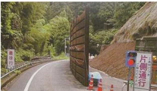
写真-3 仮復旧状況(同上) 6)
