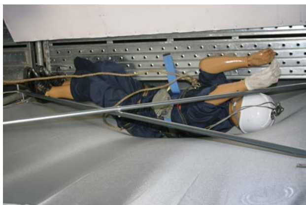
写真-1 倒れこんだ作業員による作業床とメッシュシートとのすき間の広がり
