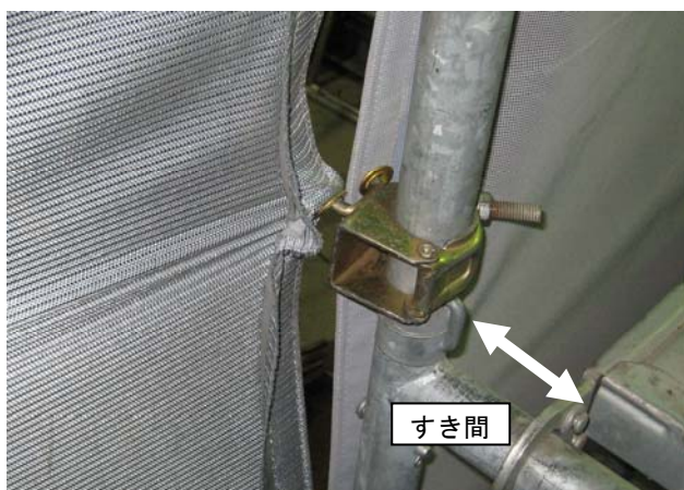
写真-2 メッシュシートを金具により強力に固定
