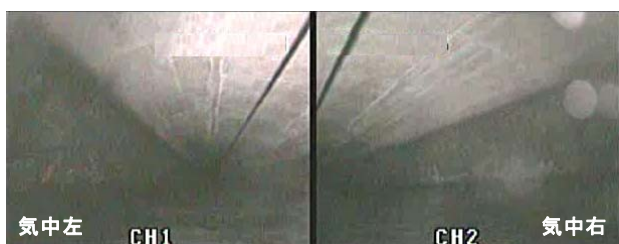
写真-2 気中映像(水路幅 約2m 水面から天井まで約1m)
