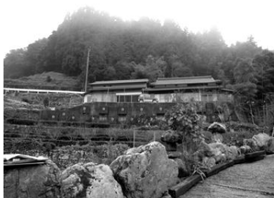
写真-1 A 地区の周辺状況
