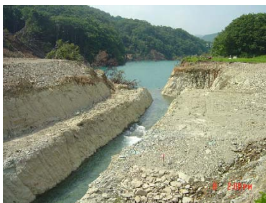
写真-4 市野々原地区で 2 次災害防止のために 建設された仮排水路 (2008 年 8 月 8 日撮影)
