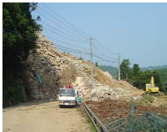
写真-2 白崖地区の災害復旧工事 (2008 年 8 月 8 日撮影, 右手が磐井川)
