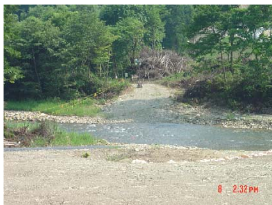
写真-3 最初の重機搬入路の渡河地点 (2008 年 8 月 8 日撮影)
