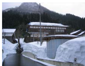
写真7 近所の軒先倒壊と積雪状況
