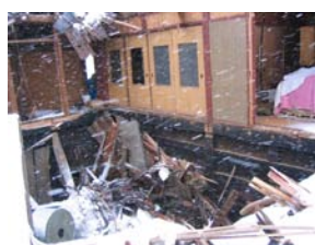
写真5 2階屋根から見た内部
