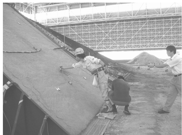
図-6 傾斜計の設置状況
