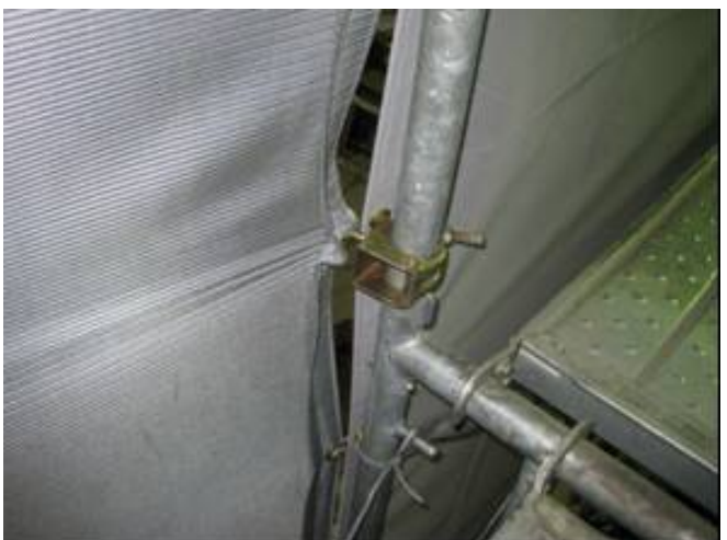
写真-6 両サイドで金具により強力に固定した場合
