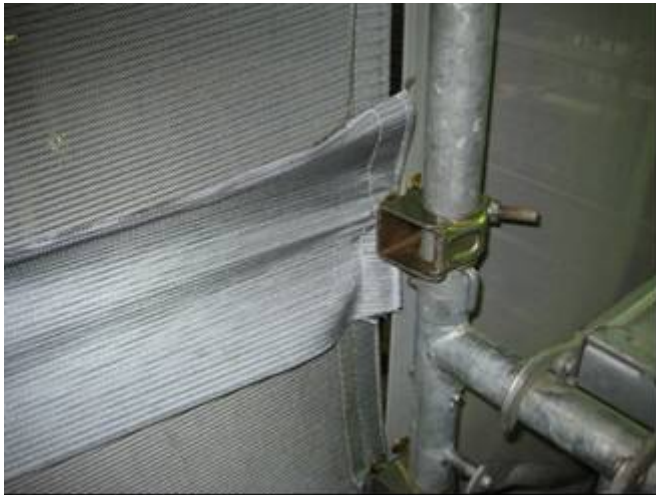
写真-7 メッシュシートを2枚重ねにして伸びを抑えた場合（金具併用）
