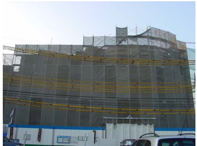
写真-1 仮設足場に取り付けられたメッシュシート
