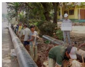
写真-1 パイプライン敷設のために 人海戦術により掘削 (保護具の着用は見られない)
