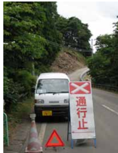
写真 - 4 2008年岩手・宮城内陸地震における土砂崩落
