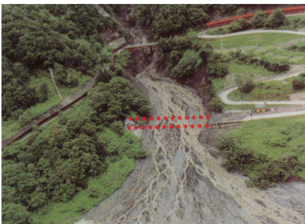
写真-1 国界橋の被災(1995年7月水害)
