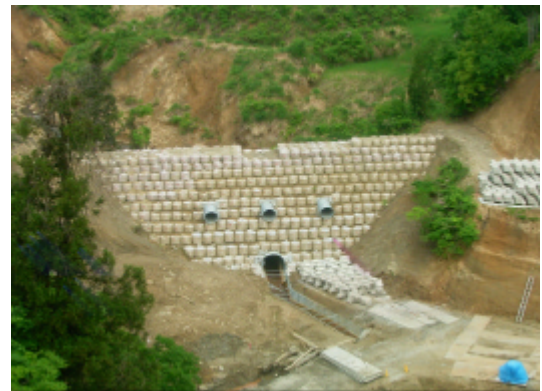
写真-3 仮締切り(土囊)築堤
