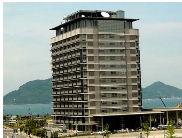
写真-2 サポート合同庁舎
