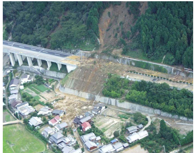
写真-1 H16.9 台風21号による土砂崩壊(新居浜市)
