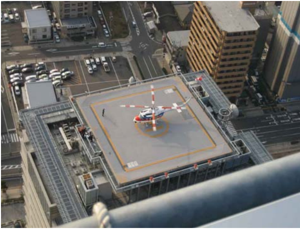
写真－４ 合同庁舎屋上ヘリポート
