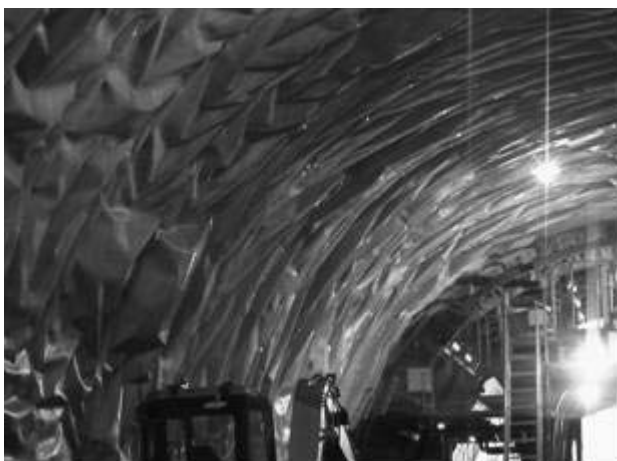
写真-4 防水シート（手前）と覆工コンクリート（奥）
