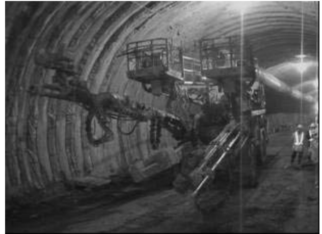
写真-5 トンネル掘削用建設機械（ジャンボ）
