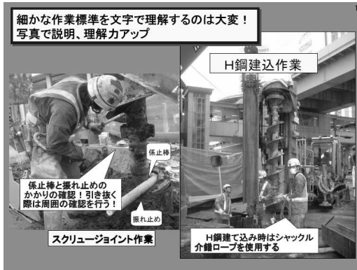
写真-3-2 写真で見る「作業標準」の例(杭打工より)
