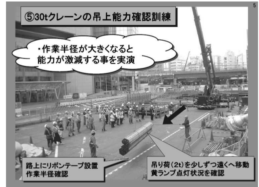
写真-8 クレーンの吊上能力確認訓練
