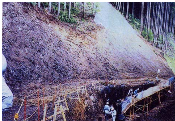
写真-1 斜面下での擁壁工の施工状況
