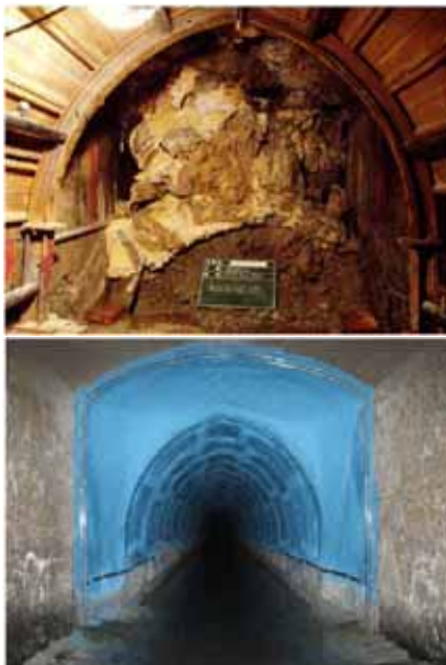
写真-2 復旧工事の状況
