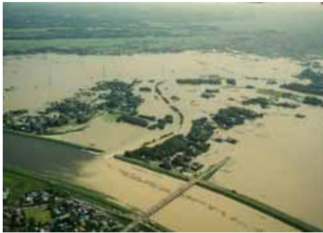
写真 2 小貝川左岸高須：構造物周りからの漏水による決壊（昭和56年8月洪水） （左が小貝川の上流、右から利根川本流からの逆流が押し寄せている。）
