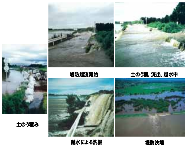
写真 1 小貝川左岸赤浜：越水による堤防決壊 5) (昭和61年8月洪水) ( は左側, ~ は右側, は上側が, 小貝川)
