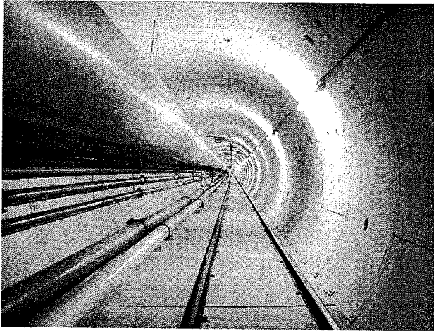
写真-2 シールド坑内
