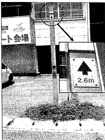
図-8 台風 23 号実績水位の明示例
