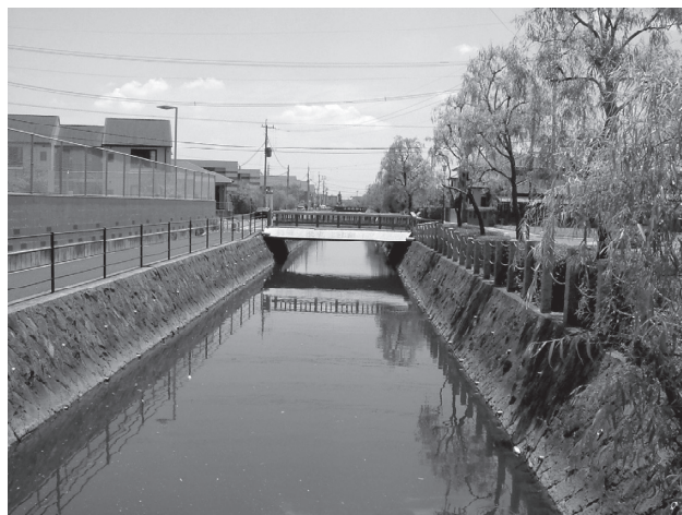
写真-3 コンクリートブロック積み護岸を備えた雨水排水路の例
