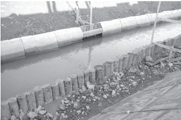
写真-7 杭柵工の施工状況（平成17年3月）
