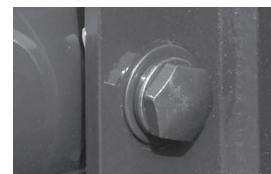
図-13 歩行者の安全性に配慮した丸頭の六角ボルト
