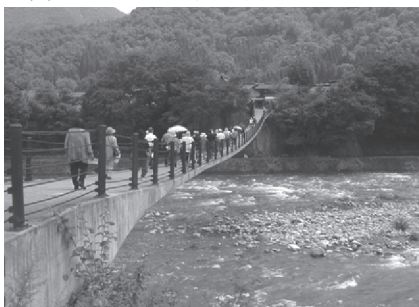
写真-4 であい橋 17)
