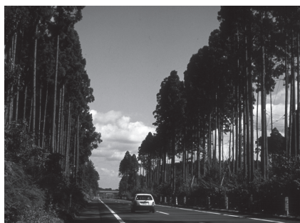
写真-10 千葉東金道路・山武区間 23)
