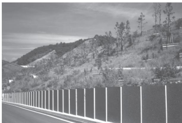
写真-14 重ね合せ擁壁(エッジの見える側)
