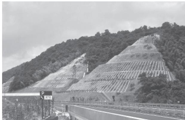
写真-19 ラウンディングとのり枠
