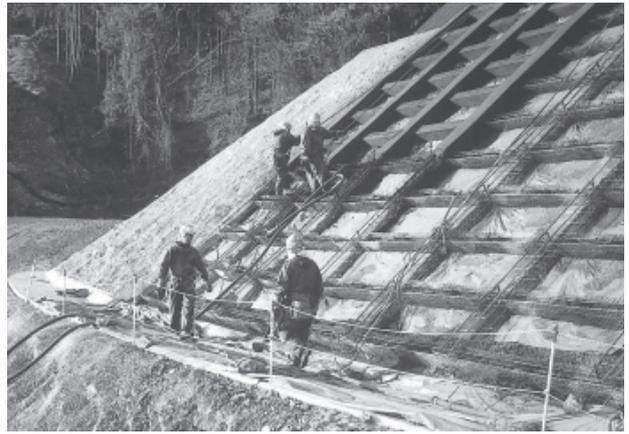
写真-22 吹付けコンクリートによる施工
