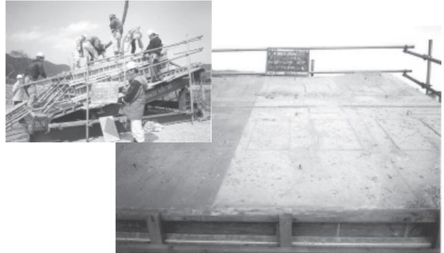
写真-9 アーチリブのコンクリート打設試験
