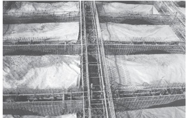
写真-23 吹付けのり枠（吹付け前）
