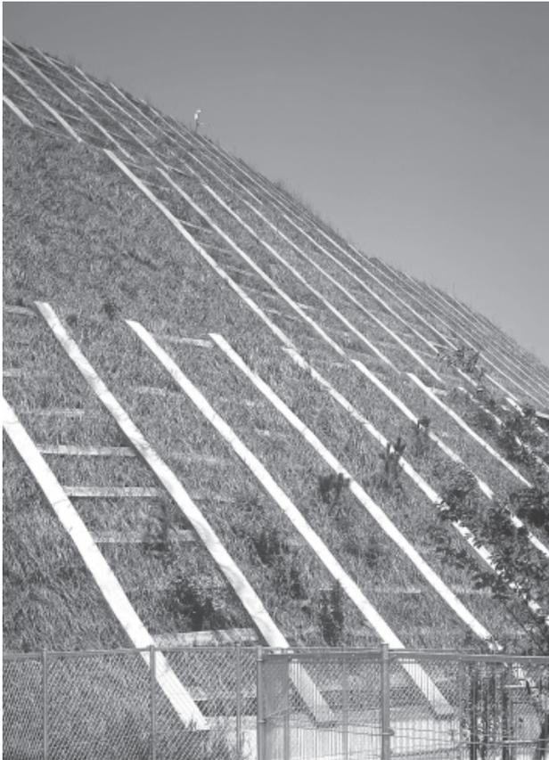
写真-20 デザインしたのり枠工（アイビーム）
