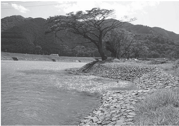
図-14 竣工した護岸 (No.67 付近)。手前が No.67～70 区間の三割勾配の護岸で、奥が河畔林まわりの一割五分勾配の護岸。
