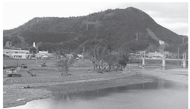
図-12 施工中のスロープ(河畔林の奥)
