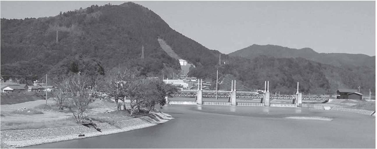
図-17 下流側から見た河川公園（施工中）と河戸堰の風景
