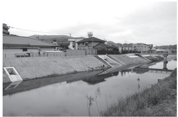
写真-2 対象河川施工完了区間
