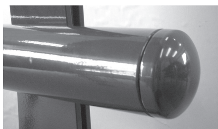
図-15 横梁端部のキャップの基本形
