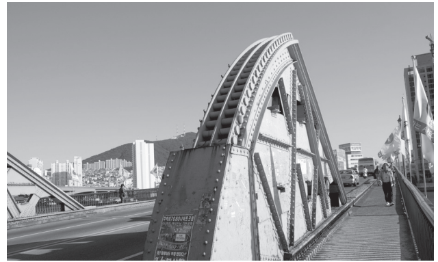
図4 影島大橋の跳開装置のギア
