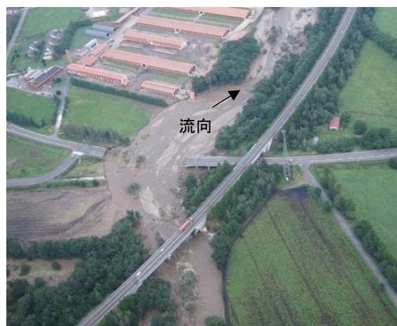
図-1 平成28年8月北海道豪雨による十勝川水系小林川に架かる橋梁の被災状況
