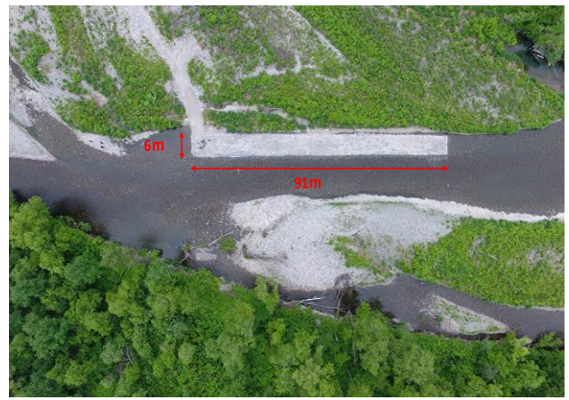
図-3 置土設置状況
