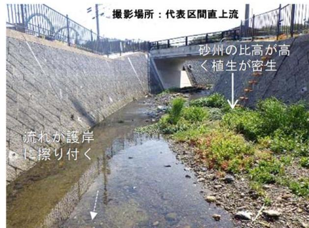
写真-5 分散型落差工の未設置区間の状況
