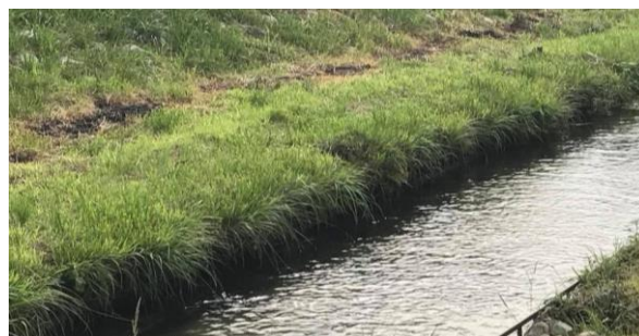
図-3 施工後15年後の鑄田籠護岸
