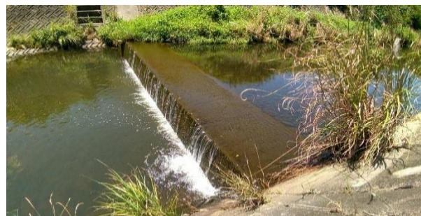
図-12 工夫の余地がある河川横断構造物
