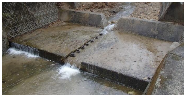
図-6 切欠き魚道の完成
