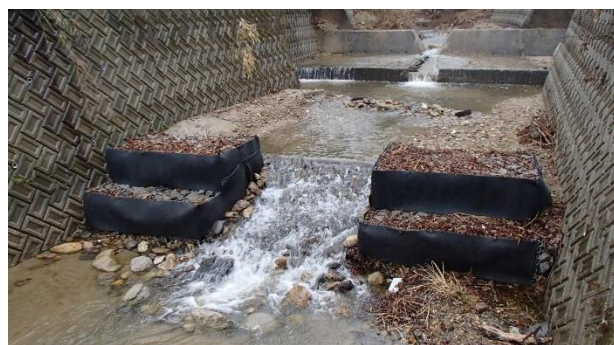
図-9 ふとんかごの設置および土砂の堆積状況
